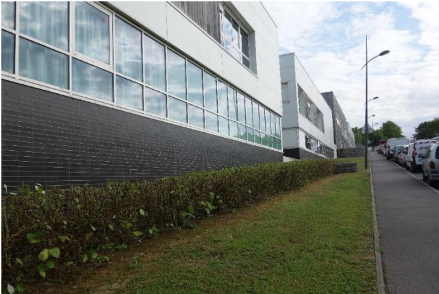
Bâtiment, haie et gazon très entretenu* Photos prises dans la zone d'étude – ECOTER 2018
