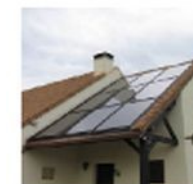
Implantation sur une annexe accolée à la construction principale
