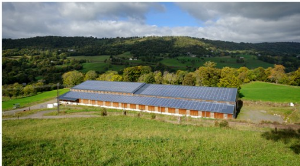
Stabulation couverte de panneaux photovoltaïques à Raulhac (Cantal)
