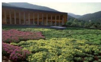
Toiture végétalisée semi-extensive Source : www.dkomaison.com
