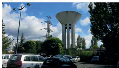
3 - L'aqueduc et la ligne à haute tension depuis le secteur des Tuileries
