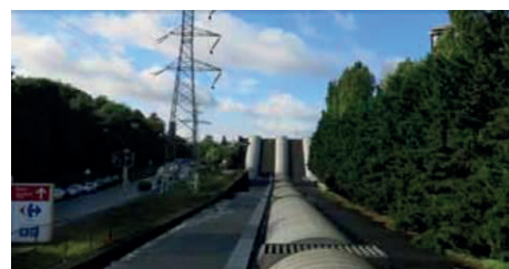
5 - La gare du RER, la ligne haut tension et la RD310
