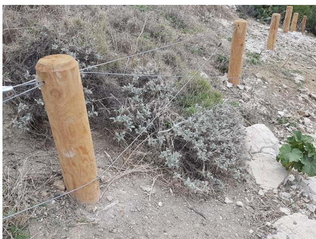
Exemple de clôture en bois à poser autour des espaces de quiétude, afin de décourager les intrusions et préserver les espaces de nature Source : ECOTER, 2020
