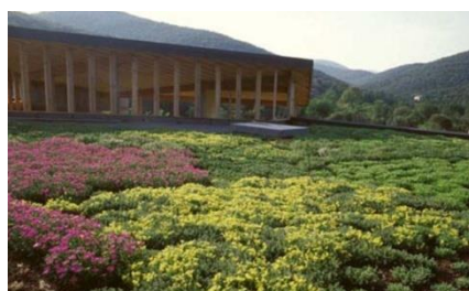
Toiture végétalisée semi-extensive Source : www.dkomaision.com
