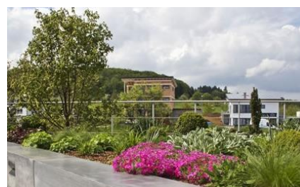
Toiture végétalisée intensive Source : www.zinco.ch
