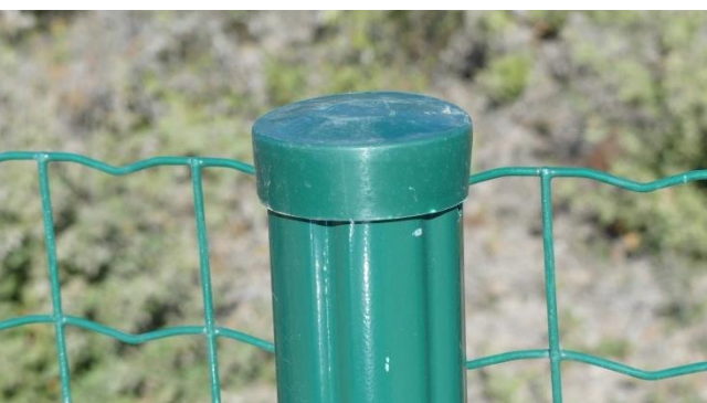
Exemples de clôture dont le sommet des poteaux a été obturé – DRYOPTERIS, 2017
