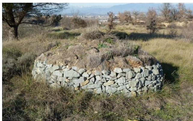
Exemples de gîtes murets avec interstices (Source : apbs)
