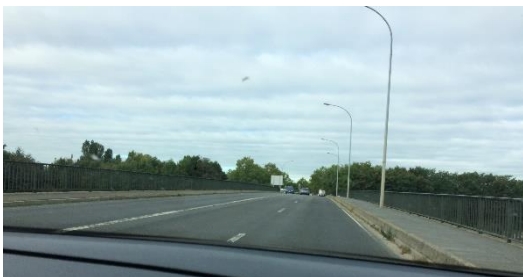
3 – Franchissement de l'A6 sans aménagement cyclable le long de la RD310
