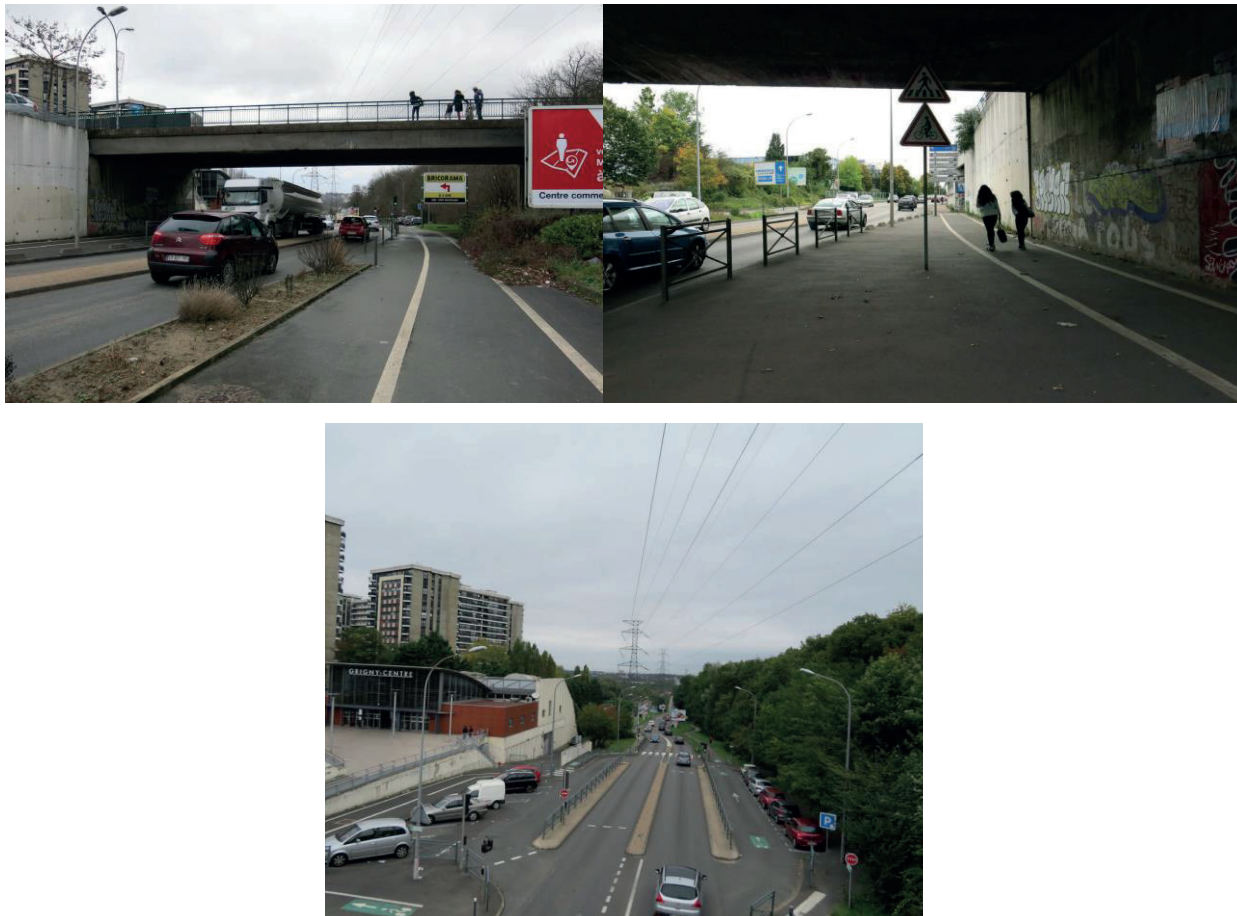
Figure 110 : Photographies des aménagements cyclables existant (Source : EPFIF)
