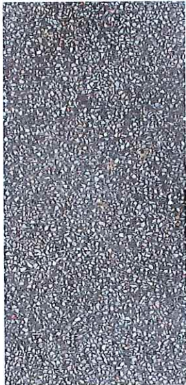
Figure 70. Enrobé poli mis en oeuvre au sein des rues et Boulevards.
