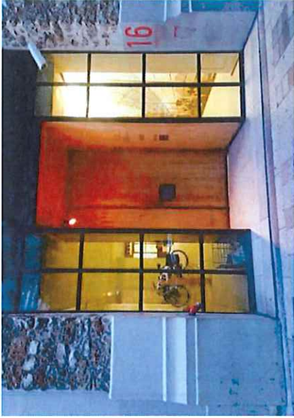
Figure 52. Accès local vélo mutualisé avec un accès du bâtiment - Bureaux AREP, Paris
